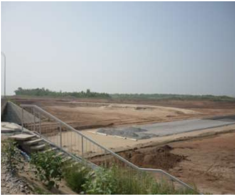
Фото 4. Строительство автотрассы от Кировского моста. От стариц 10 км.
